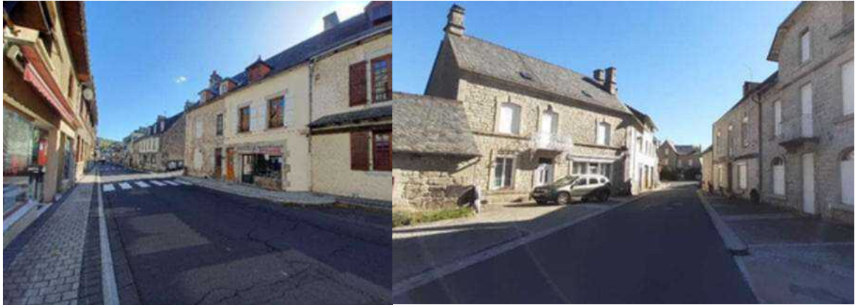
Aménagement piéton dans les bourgs de Riom-ès-Montagnes et de Menet
